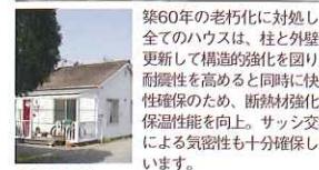
築60年の老朽化に対応し、全てのハウスは、柱と外壁を更新して構造の強化を図り、耐震性を高めると同時に快適性確保のため、断熱材強化で保温性能を向上。サッシ交換による気密性も十分確保しています。
